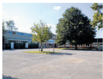
Die Asphaltwüste an der Schule soll aufgebrochen werden.
