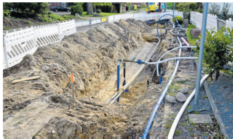
Im Zuge der Sanierung werden Trinkwasserleitungen verlegt. Fotos: Beneke
