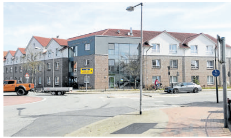
Der Neubau entsteht rechts neben der Seniorenresidenz.
