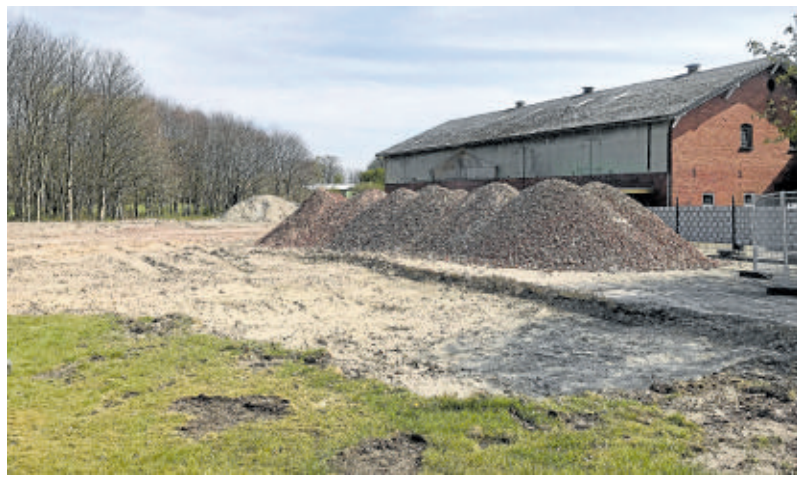
Die alten Gebäude auf dem Bauplatz wurden bereits abgerissen.
